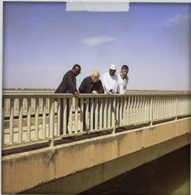
Visite de l'écluse
