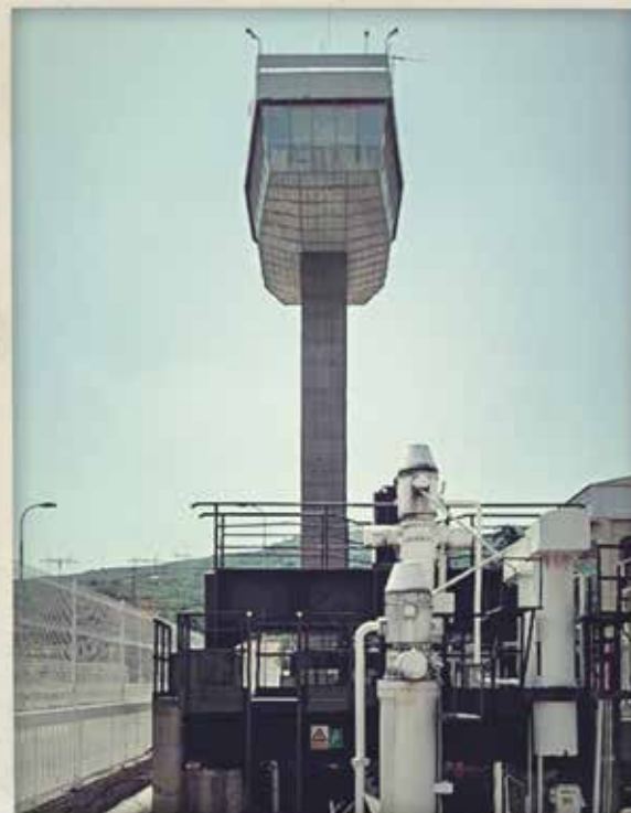
Tour de contrôle de l'écluse côté Serbe
