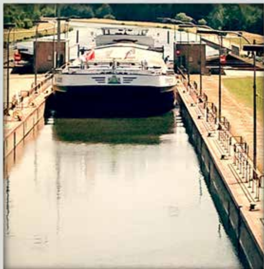
Le transport de marchandises via le canal Main Danube, écluse d'Hilpoltstein
