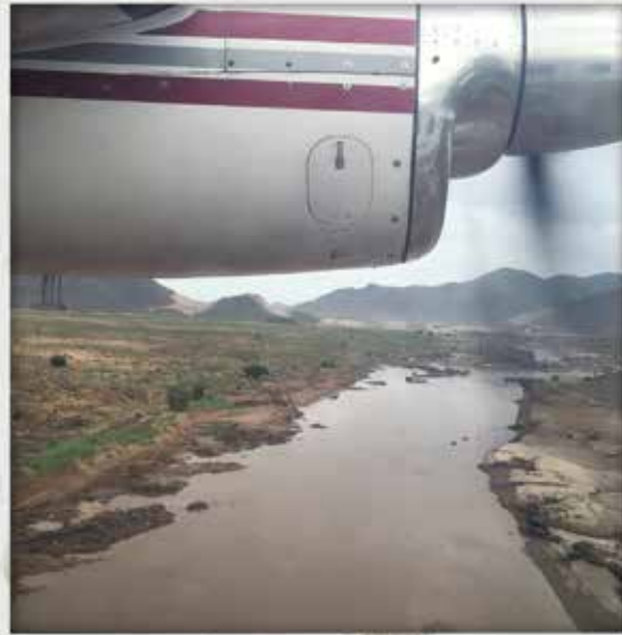
Arrivée à proximité du barrage Renaissance
