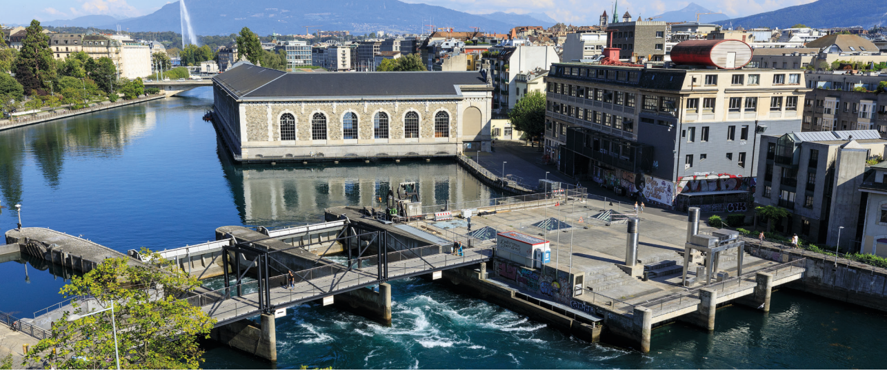
Barrage du Sujet, sur le Rhône, à Genève
