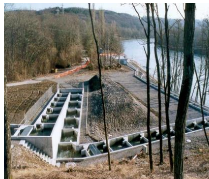
Passé à poissons au barrage de Verbois
