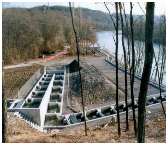
Passé à poissons au barrage de Verbois
